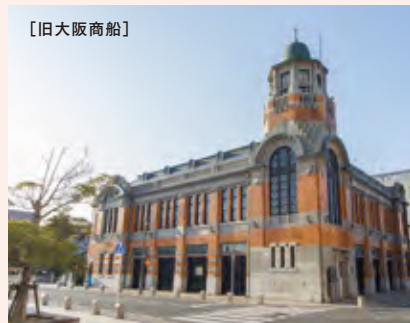
1917(大正6)年に建てた大阪商船門司支店を修復。1階は「わたせせいぞうギャラリー」となっています
